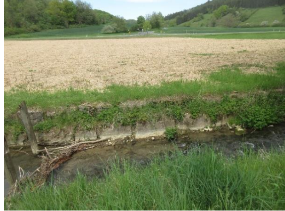
Balbach mit Sohsschalen auf Höhe der Einmündung des Deubachs
