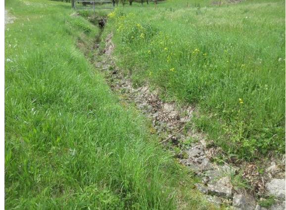
Lämmertsberggraben mit Sohlverbau
