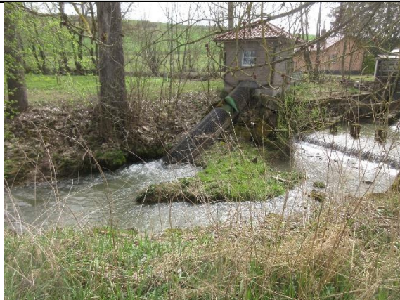
Wehr mit Sohlschwelle
