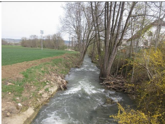
Umpfer mit Uferverbau
